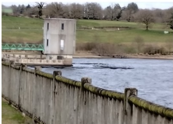
Tour de contrôle barrage de Lavaud
