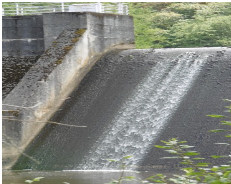
Barrage de l'Issoire
