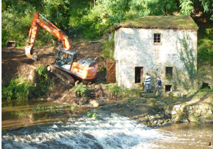
1. Travaux d'aménagement de la berge du moulin pour la remise en état du chemin d'accès depuis les hauteurs du quartier Saint-Maxime.
