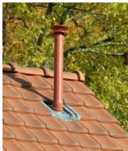
Ventilation secondaire Extracteur statique
