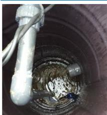
Un poste de relevage peut parfois s'avérer nécessaire lorsqu'il n'y a pas assez de pente ou de place sur le terrain.
