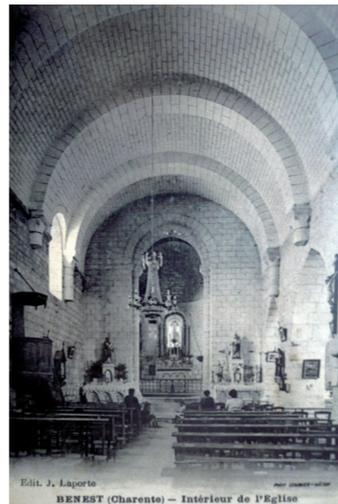
Sa voûte en berceau s'appuie sur des arcs doubleaux qui reposent sur des chapiteaux ornés de motifs géométriques. Ces chapiteaux reposaient tous initialement sur des colonnes; certaines ont été tronquées, d'autres ne descendent plus qu'à mi-hauteur et reposent sur des corbeaux. Au sud de la seconde travée, une plaque fait face au portail d'entrée; elle commémore la confirmation du privilège de franchise de Benest par François I<sup>er</sup> en 1517.
