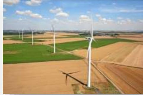
La prise au vent de ce type d'éoliennes est importante même s'il faut au minimum des vents de 10 km/h pour commencer à donner du mouvement aux pâles. Par ailleurs, au-delà d'un vent qui atteint 90 km/h, elles s'arrêtent automatiquement de fonctionner, car la force motrice engendrée par le mouvement pourrait fragiliser la structure elle-même. La hauteur totale de ces éoliennes varie entre 25 et 180 mètres pour une puissance qui va de 100 kW à 5MW.
