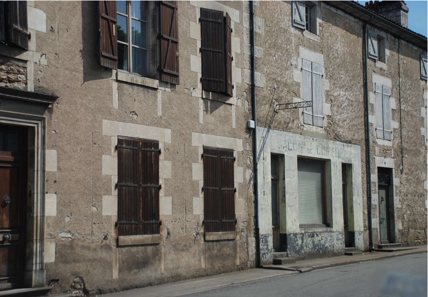
Rue de Champagne-Mouton: encadrements de pierre de taille et moellons calcaires enduits au mortier de chaux et de sable local
