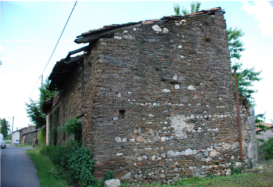
Mur composé en mélange de schiste et quartz à Beaussac, Montemboeuf
