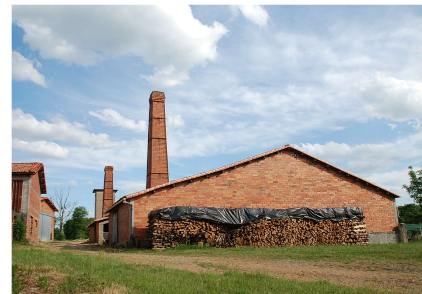
Tuilerie d'Etamenat, entre Cherves-Chatelars et Vitrac-Saint-Vincent
