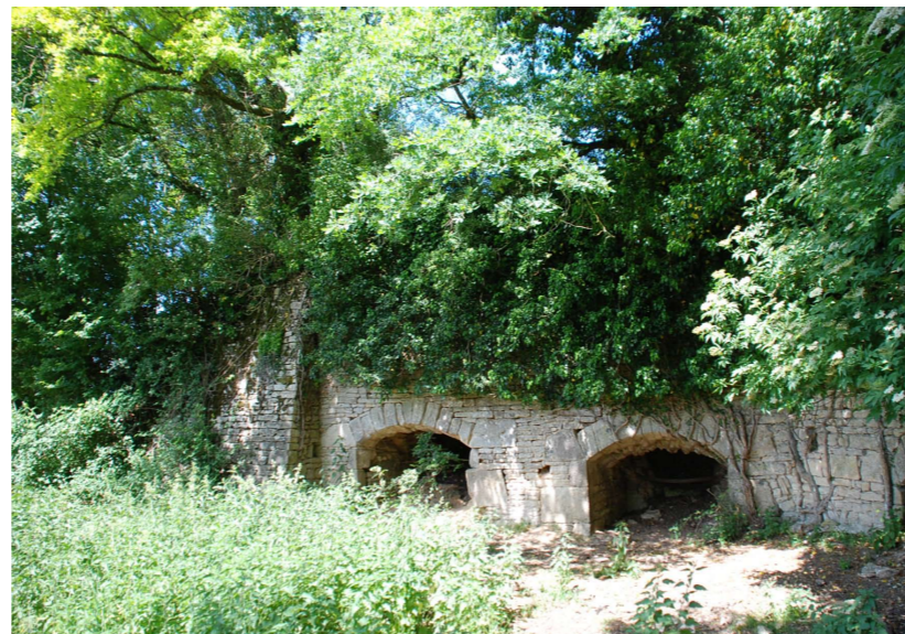
Les fours à chaux de Benest, à quelques mètres du village disparaissent sous la profusion de la végétation; tout autour, les déchets de silex qui étaient inclus dans la pierre calcaire.
