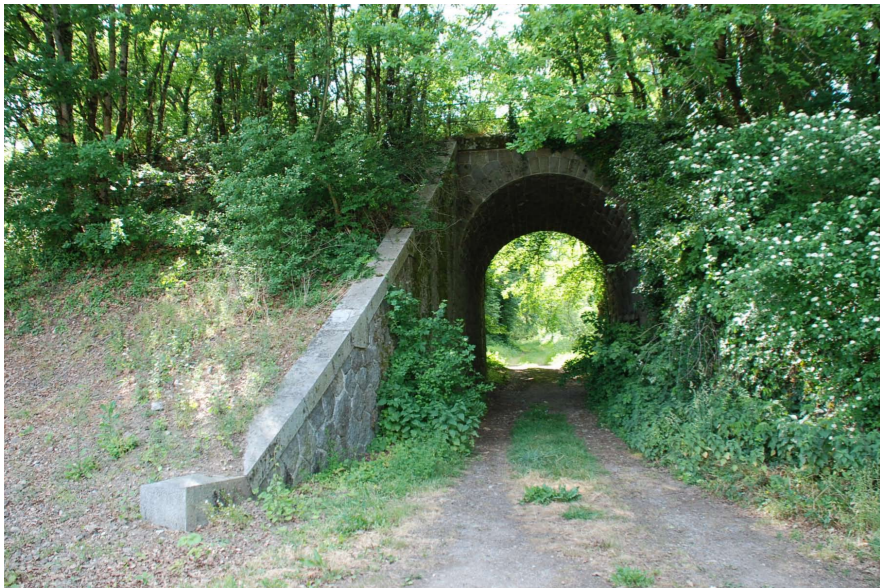
Tunnel sous l'ancienne voie ferrée, Sainte Radegonde, le Moulin de l'île
