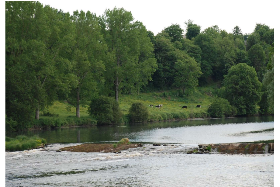
Entre Confolens et Ansac, seuil transversal au fleuve
