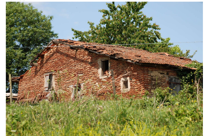
Maison construite en «mureuse», tuiles mécaniques déclassées à Thauzac, entre Montemboeuf et Massignac
