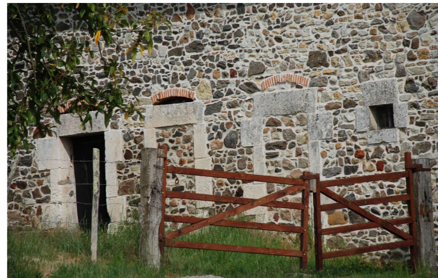
Ferme entre Laplaud et Loubert ; brique, calcaire taillé, blocs de schiste et de grès ferreux se côtoient dans la composition du mur
