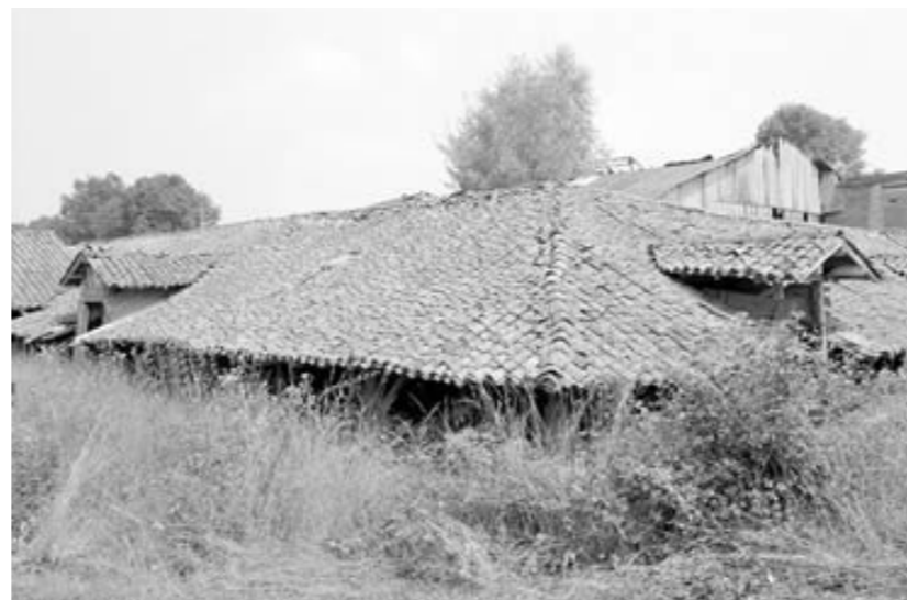
Séchoirs à air libre Tuilerie et briqueterie Delage, Abzac, Chardat © Inventaire général
