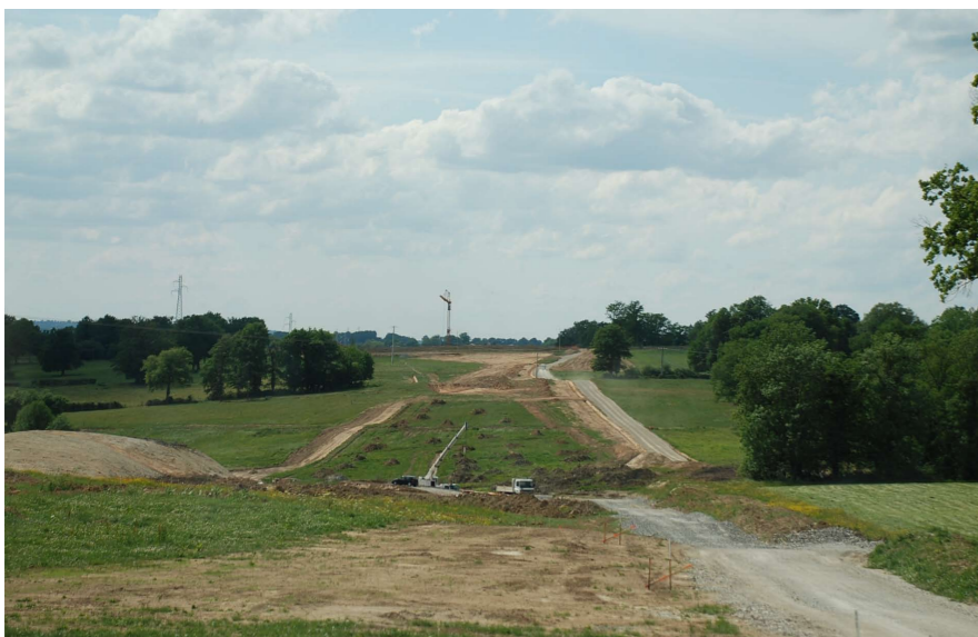
Dans l'axe des travaux, une percée dans le paysage
