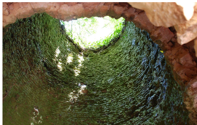
Détail de l'intérieur de la base d'une cheminée
