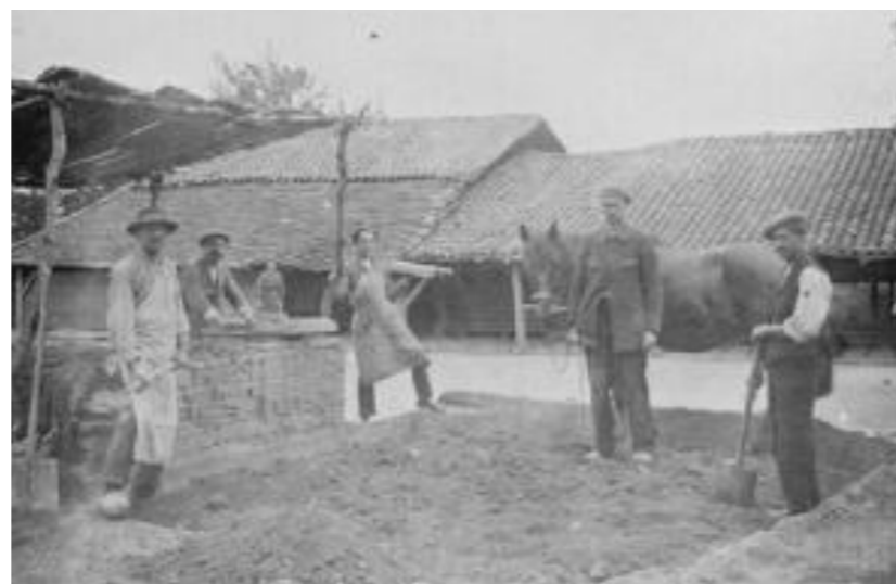
Ouvriers préparant l'argile à la tuilerie de Chambon à Saint-Maurice-des-Lions - Photo ancienne du début du XXe siècle © A. privées - Reproduction Service régional de l'inventaire de Poitou-Charentes / A. Maulny, 1989
