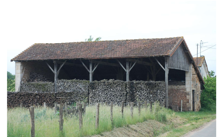
Grange à foin ancienne en bois sur murs porteurs en pierre, la Breuille, Les Pins
