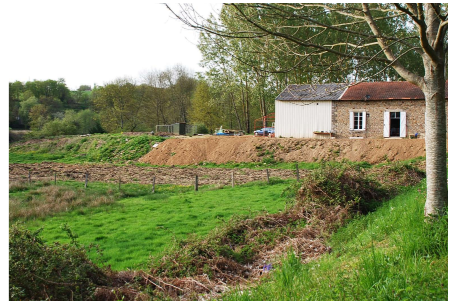
Au nord de Confolens, remblai dans le lit de la Vienne
