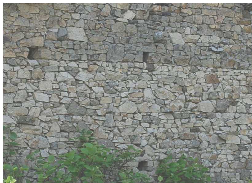
Esse: blocs de granit montés à sec. L'éclatement des blocs pour la construction donne à voir un granit plus clair que les pierres employées brutes qui sont teintées d'oxydes.
