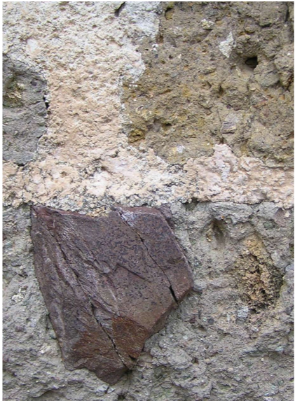
Moellons employés dans la construction des thermes de Chassenon, photo Rosier
