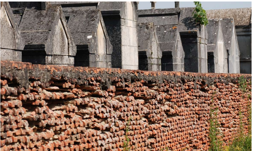
Cimetière de Roumazières et sa «mureuse», muret de tuiles mécaniques déclassées et empilées
