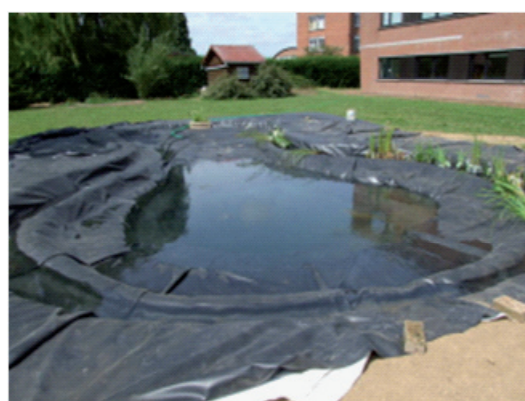
Figures : Illustrations de la création d'une mare. (Source : gauche – Agri environnement / centre et droite : Nature bassin dans le cadre de la constitution d'une mare pédagogique)
