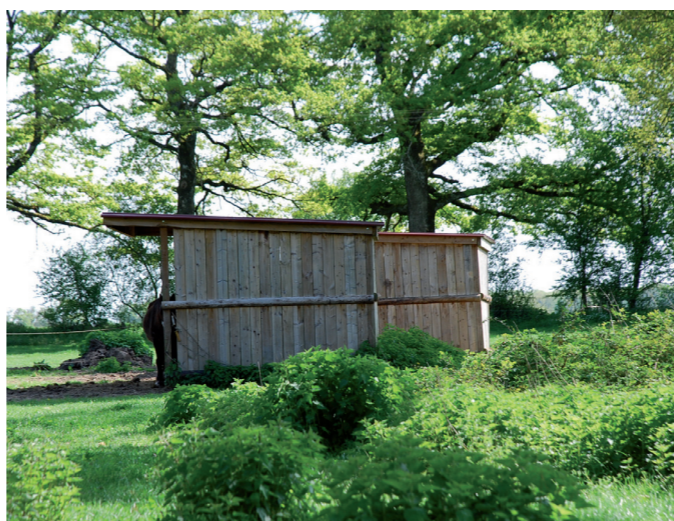
Abri à chevaux en bois, Oradour-Fanais
