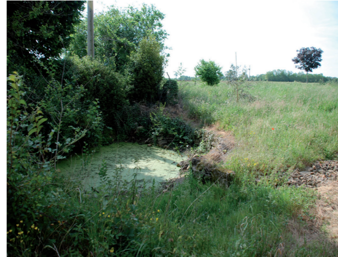
Cherves-Châtelars, mare maçonnée dans un hameau agricole
