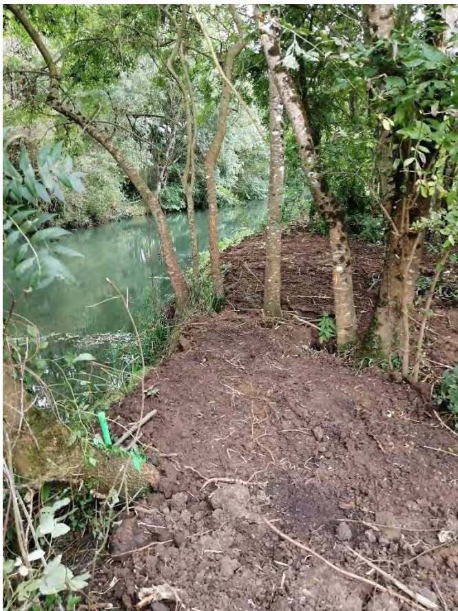
Berge du bief de Brion
